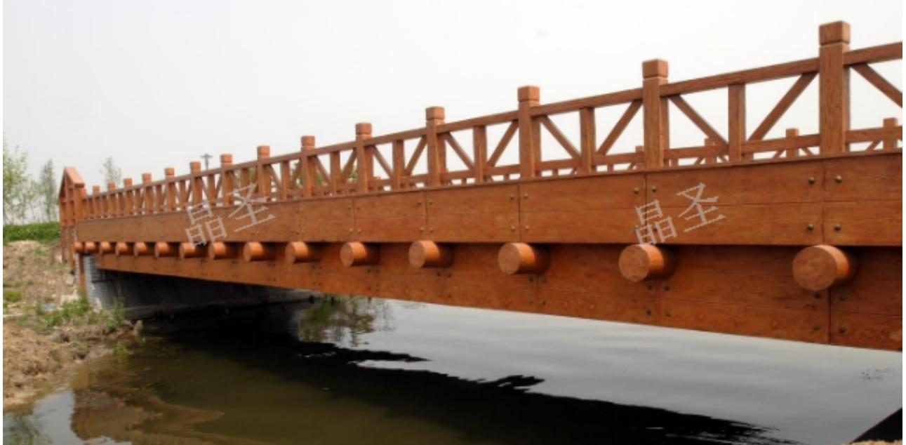
桥梁景观装饰栏杆的类型有哪些呢？类型一：栅栏式。所谓栅栏式，就是栏杆与立柱按等间距或有规则变化排列，用一根通栏扶手（或断开）链接。这种栏杆一般不加雕饰，只求规格严整、简洁明快、连续流畅、施工简便，适用于各种桥型。类型二：栏板式。通常情况下，栏板式桥梁栏杆又可分实体栏板、镂空栏板。实体栏板是在两个立柱之间置以预制的栏板，上面常常有各种雕饰来体现民俗风情，增加情趣感，适用于中小型石桥、混凝土桥及园林桥。对于长大桥也采用实体护栏，则主要突出其安全防护作用，可兼作“饰带”。镂空栏板式是将栏板按设计的图案和纹样以不同的方式镂空，留出不同几何形状的孔洞。此时不只可以通过镂空的轮廓和形状形成刚柔、虚实、静动、疏密的美感，同时透过空隙，风景若隐若现，引起人们的遐想，增加情趣，达到无中求有的艺术效果。
