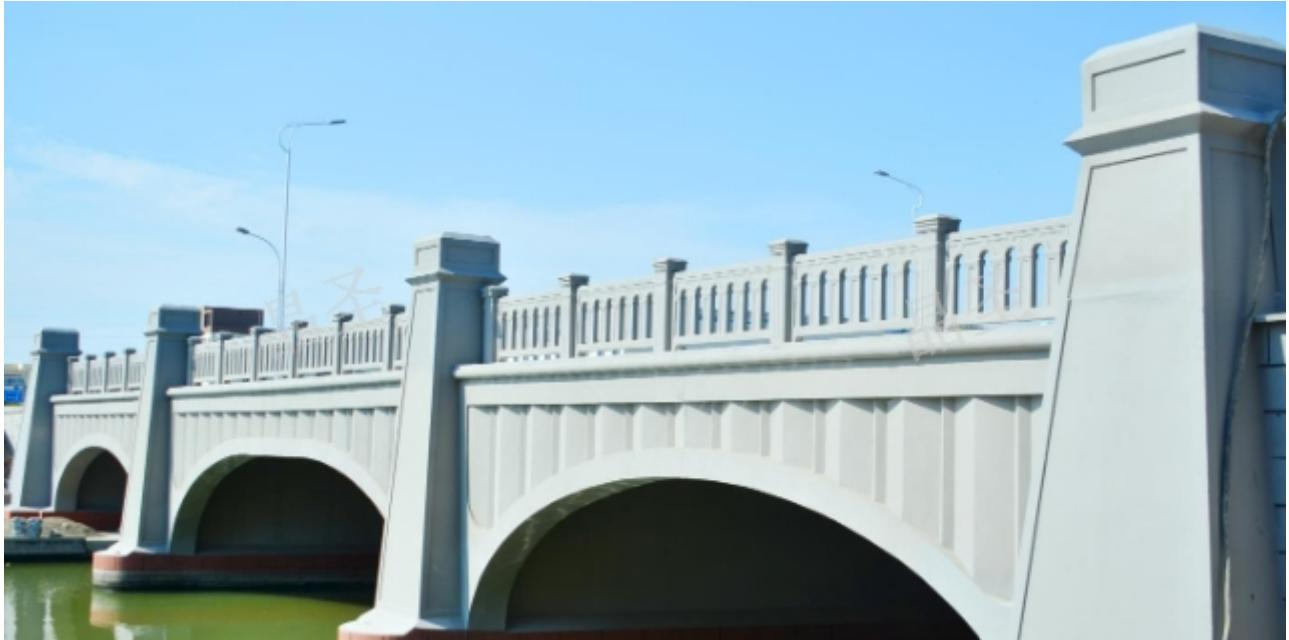
桥梁景观装饰晶铸石栏杆主要采用特种水泥加钢筋及石英砂等材料按一定的比例通过模型浇注形成的栏杆，后期在经过特殊的工艺处理成和石栏杆差不多的精造石护栏，晶铸石栏杆也可以和其他形式的护栏组合成不同形式的组合护栏。晶铸石栏杆有着造型美观、时尚、环保、抗老化、不易变形、造价低廉的性能优点，晶铸石栏杆可普遍用于市政、水利、公园、道路、桥梁护栏等护栏工程。随着城市建设的不断深入的发展与拓开，越来越多的园林景观开始使用并推广晶铸石护栏产品。使得晶铸石护栏产品越来越深入消费者与观众的喜爱与认可。当暮色降临金属氟碳漆喷涂后的立柱在白色灯光的照射下宛如一个个立体通透的水晶盒。上海桥梁建筑外立面装饰多少钱
